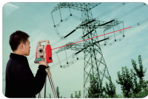
测量高架电线
